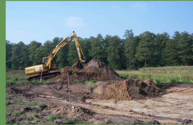
Anlage eines Laubfrosch-Gewässers
