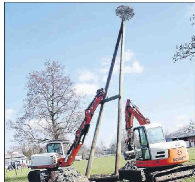
Mit Hilfe zweier Bagger wurde die Nisthilfe auf einer Wiese in Hasslinge aufgestellt. ■ Foto: Brauns-Bömermann
